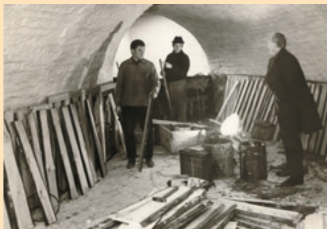
Ausbau des Schlosskellers, Aufnahme vom 12.01.1972
