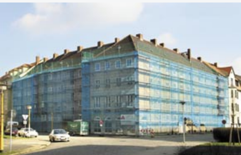
Einraumwohnungen im 2. Obergeschoss
