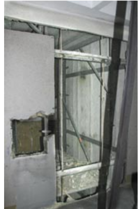
Erneuerung des Aufzuges im Eingang Nr. 41
